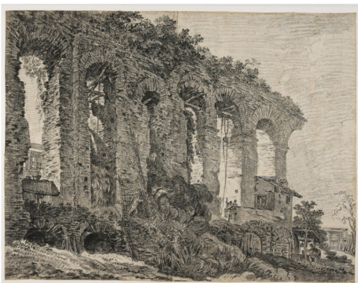
Ruines de l'aqueduc de l'Acqua Giulia , Jean-Augustin Renard, vers 1770-1780
