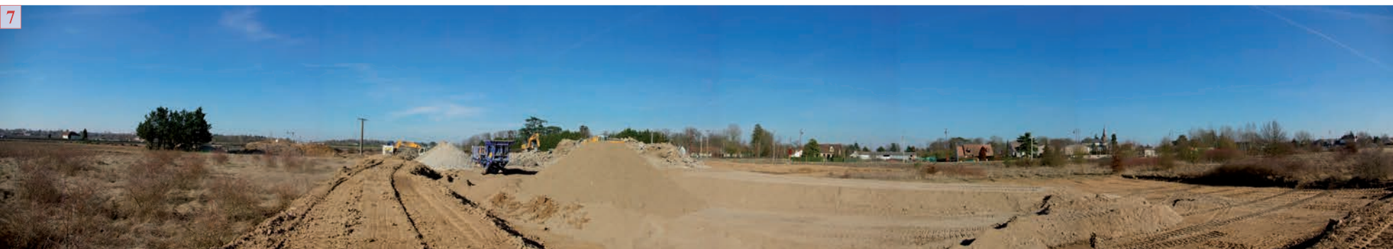
Des dépôts temporaires de matériaux vers l'impasse des Moines
