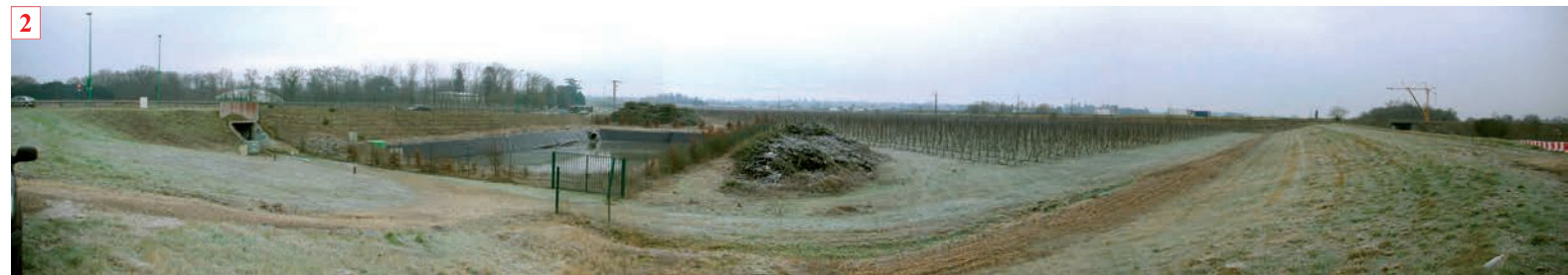
Depuis la levée, le bassin de collecte des eaux pluviales de la voirie, et les anciens fruitiers arrachés.
