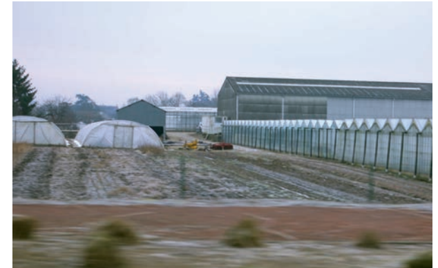
Serres de production au nord du site
