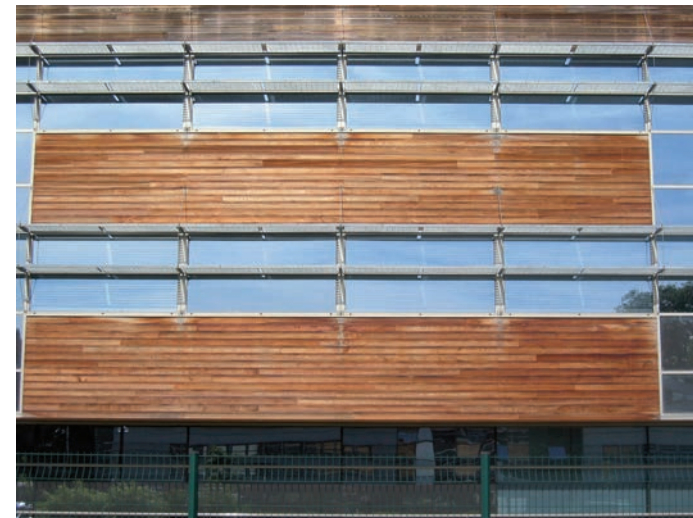
Façade bois Orléans-Charbonnière
