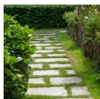
Pavés à joints enherbés
