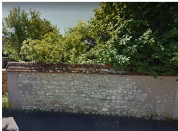
Mur en moellons
