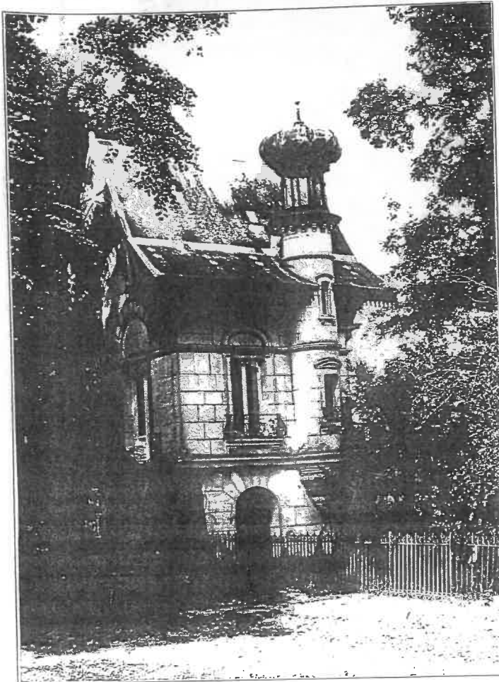
Au fond du Parc une gare à bateaux exceptionnelle a été édifiée sur la rive du Loiret à partir d'un projet attribué à Garnier, architecte de l'Opéra de Paris.
