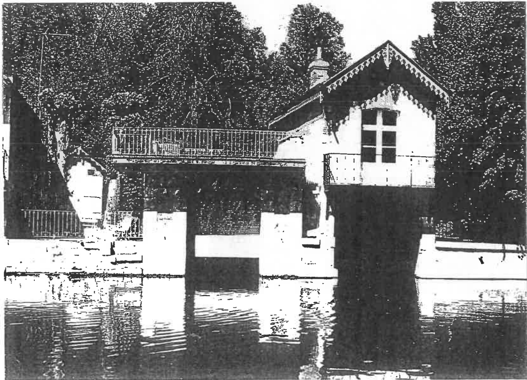
4 - Exemple de murs de soutènement en pierre, garde-corps en ferronnerie ouvragée.
