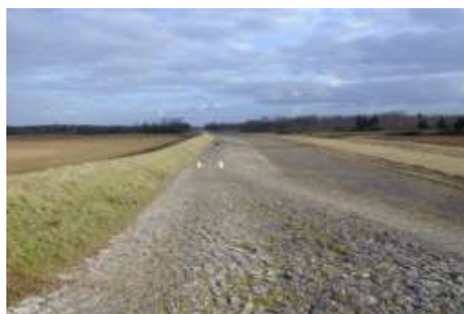
Déversoir de Jargeau
