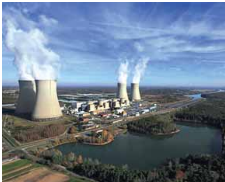
Centrale de Dampierre-en-Burly
