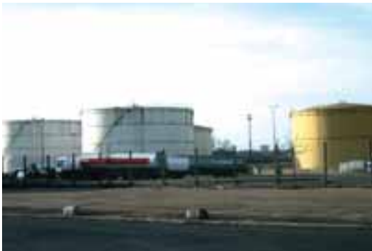
Dépôt pétrolier de Saint-Jean-de-Braye
