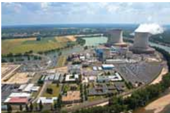
Centrale de Saint-Laurent-des-Eaux
