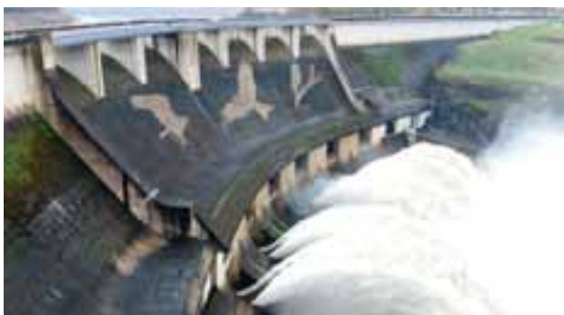
Barrage de Villerest
