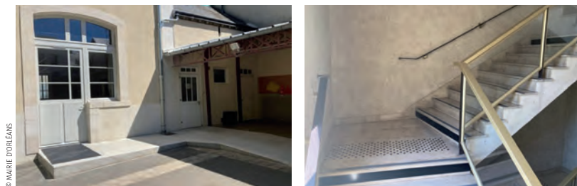
Rampes d'accessibilité, mains courantes dans les escaliers, des équipements PMR continuent d'être installés dans les écoles et lieux publics, comme le centre municipal.
