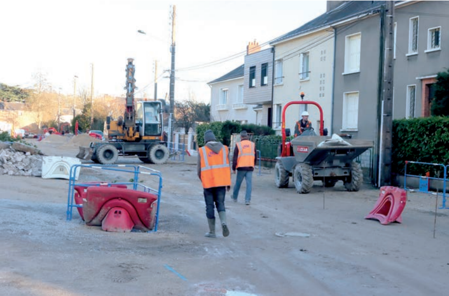
La requalification se termine rue Goyau, alors que débute celle de la rue Lavedan.
